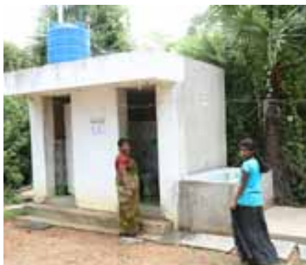
Eine der bereits durch „Hilfe zur Selbsthilfe“ gebauten Toilettenanlagen in Indien.
